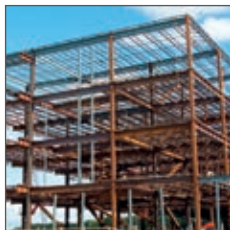
Oceľové konštrukcie AVG pre viacúčelové objekty
