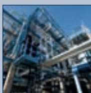
Oceľové konštrukcie AVG pre technológie, plošiny, mosty
