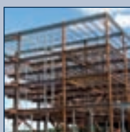
Oceľové konštrukcie AVG pre viacúčelové objekty
