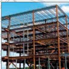
Oceľové konštrukcie AVG pre viacúčelové objekty
