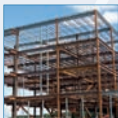
Oceľové konštrukcie AVG pre viacúčelové objekty
