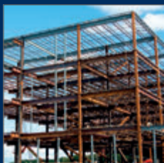
Oceľové konštrukcie AVG pre viacúčelové objekty
