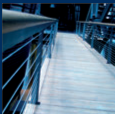
Zámočnícke výrobky a doplnkové konštrukcie
