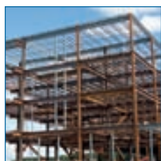
Oceľové konštrukcie AVG pre viacúčelové objekty
