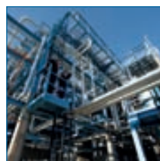
Oceľové konštrukcie AVG pre technológie, plošiny, mosty
