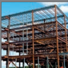
Oceľové konštrukcie AVG pre viacúčelové objekty
