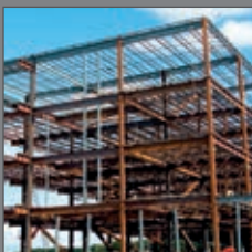
Oceľové konštrukcie AVG pre viacúčelové objekty
