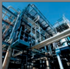
Oceľové konštrukcie AVG pre technológie, plošiny, mosty
