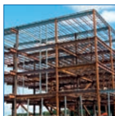
Oceľové konštrukcie AVG pre viacúčelové objekty
