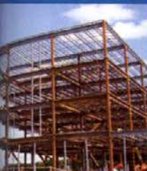
Oceľové konštrukcie AVG pre viacúčelové objekty
